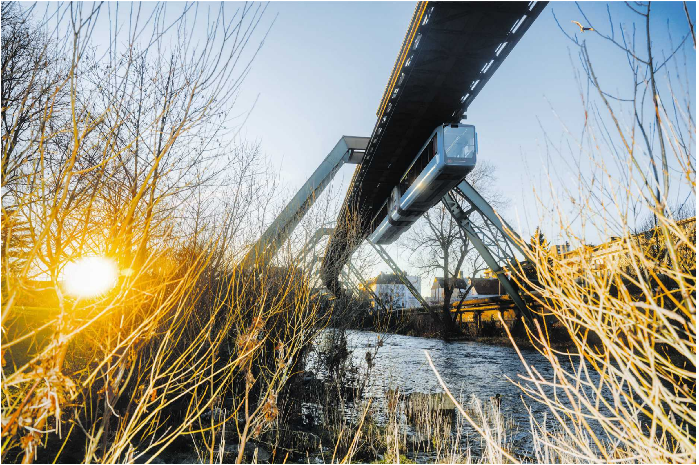
Wie das leuchtet! Die Schwebbahn hoch über der Wupper, unterwegs in die Zukunft, wohin sonst
