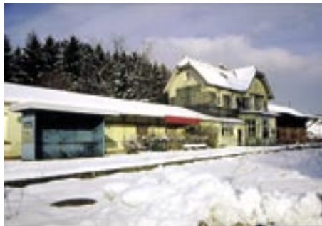
Gebäudes des ehemaligen Bahnhof W.-Küllenhahn der Sambatrasse, die jetzt als Radweg wieder befahrbar ist.
